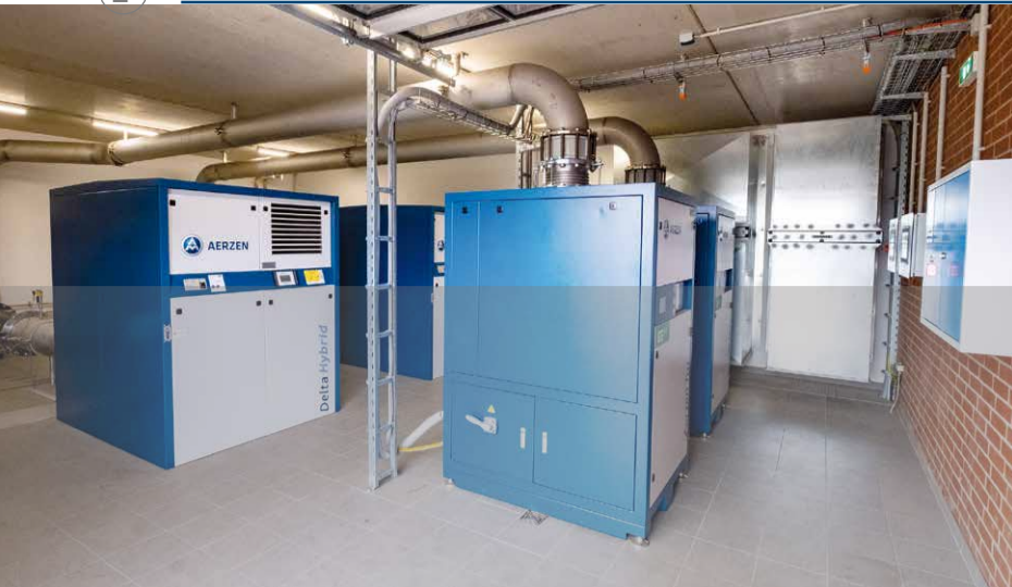
Der Verbund aus Turbogebläse und Drehkolbenverdichter schafft die Basis, den Sauerstoffbedarf in der Belebung mit maximalem Wirkungsgrad zu decken.
