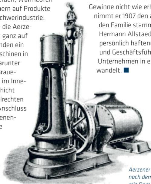
Aerzener Präzisionsgebläse nach dem Rootsverfahren mit Dampftrieb und Eisenflügeln.
