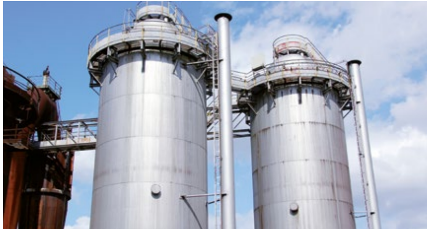
Silo Be- und Entladung
